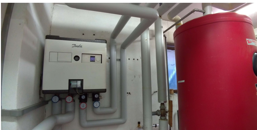
Fig 3 – boiler e scambiatore esterno
